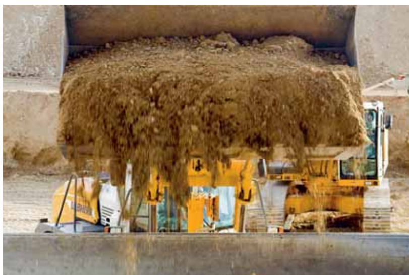
Beim Bauen muss nicht nur mit Chemikalien, sondern auch mit Neophyten belasteter Aushub gesondert entsorgt werden. Quelle: Flickr, Reinhold Brezowsky (CC BY-NC-SA 2.0)
