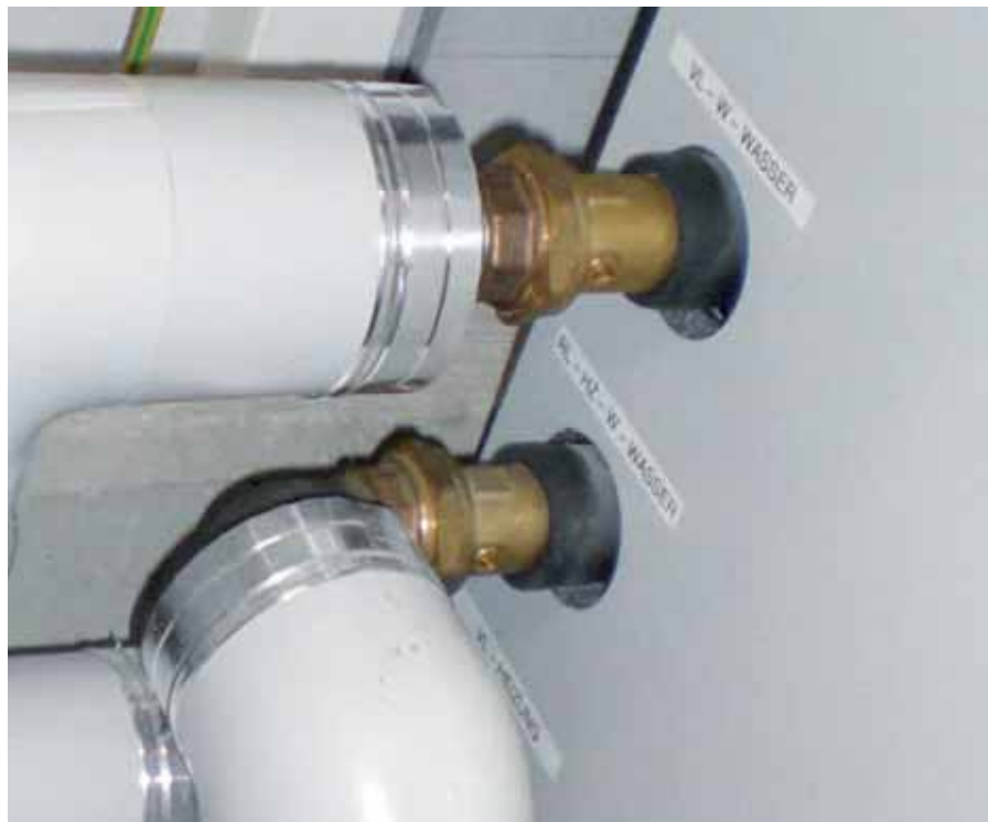
Mit dem Einsatz von flexiblen Anschlüssen (Gummierelemente) kann Körperschall vermieden werden.
