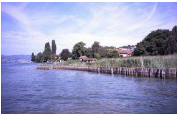
Lahnungen zum Schutz des Schilfs am Zürichsee
