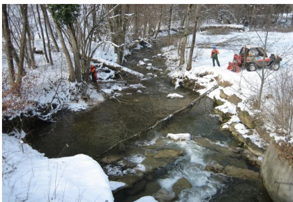
Durchforstungsarbeiten an der Reppisch
