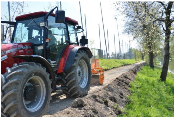
Neubau Uferweg, Glatt bei Opfikon
