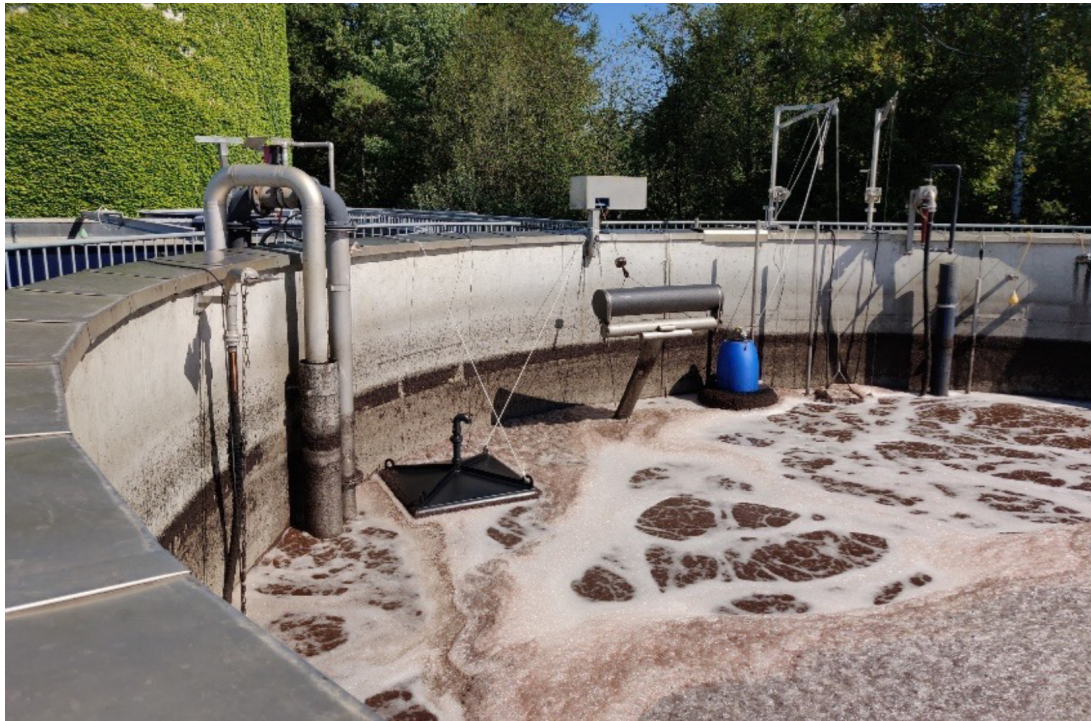
Lachgas-Probenahme mittels Gashaube in einer Faulwasserbehandlungsanlage.
