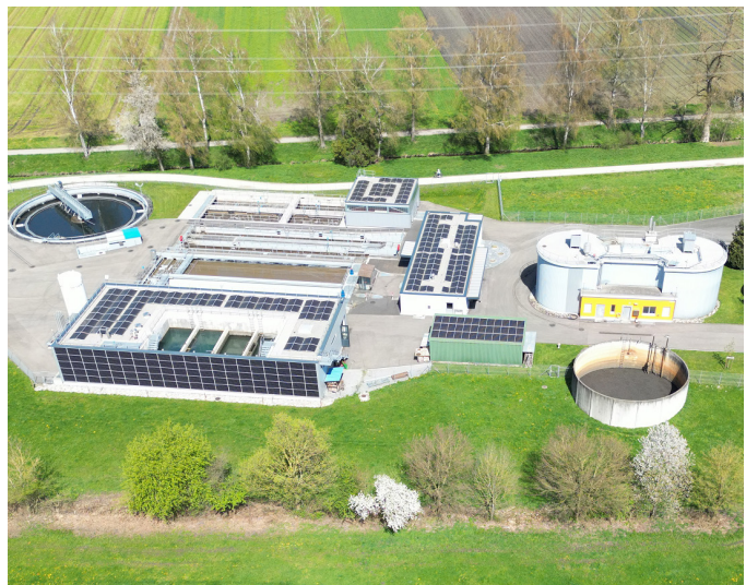
PV-Anlage auf Fassade und Dächern der ARA Buchs-Dällikon
