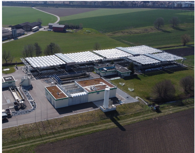
Solarfaltdach über den Becken der ARA Bassersdorf
