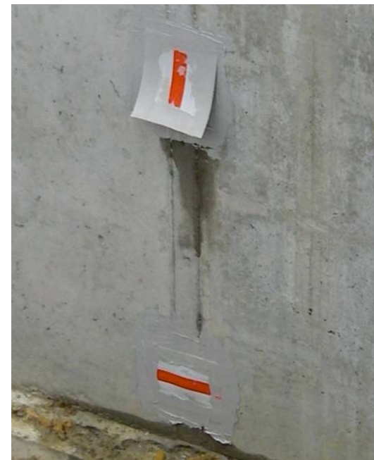
abgedichtet mit Combiflex
