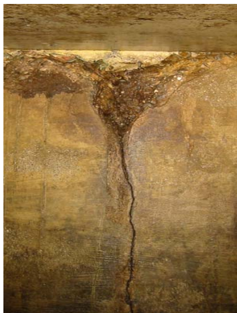
gerissene Betonwand
