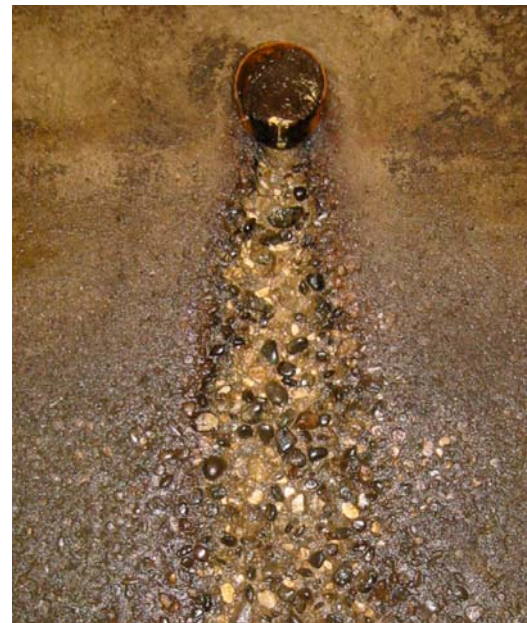
„ausgefressener“ Beton
