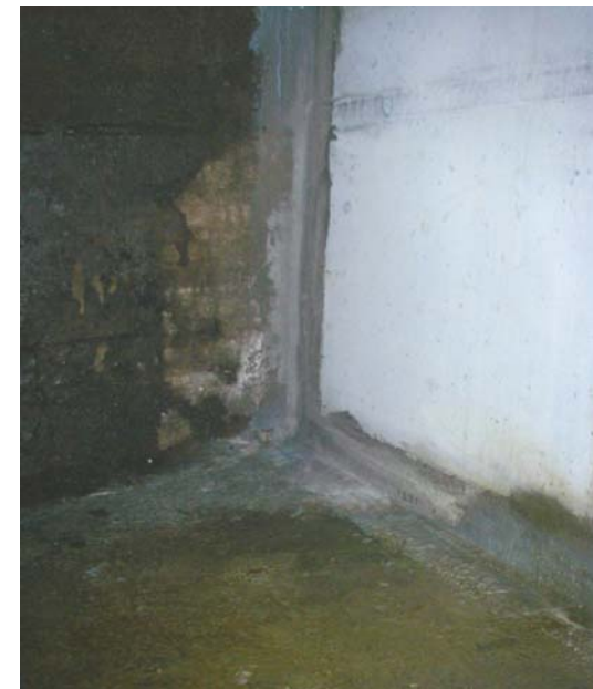
neue vorbetonierte Wand (Sanierungsvariante)
