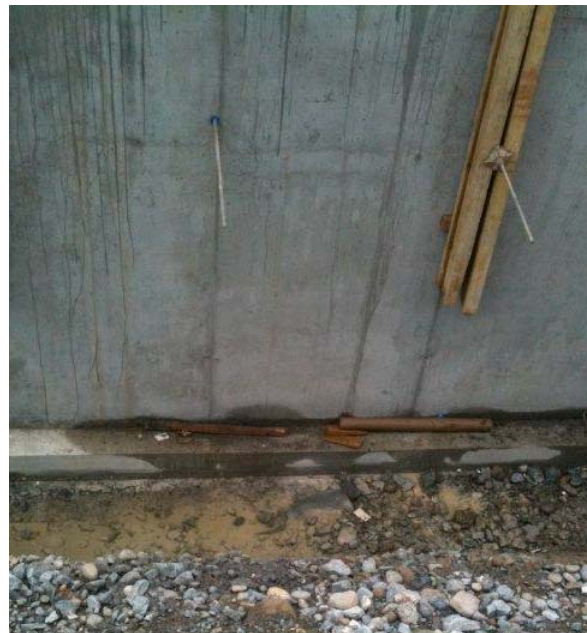
undichte Arbeitsfuge
