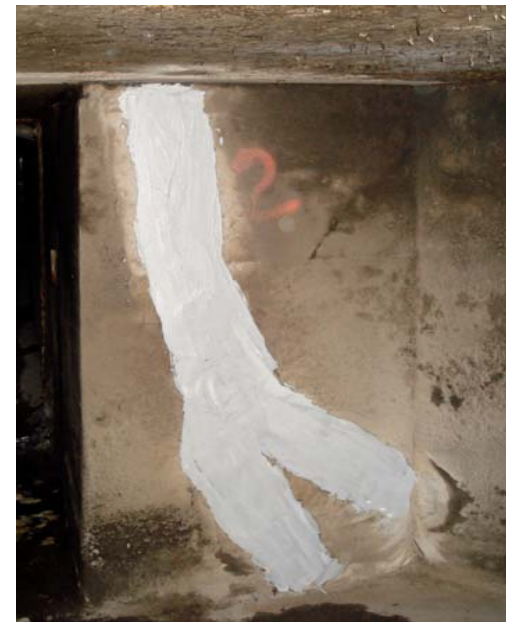
abgedichtet mit Combiflex
