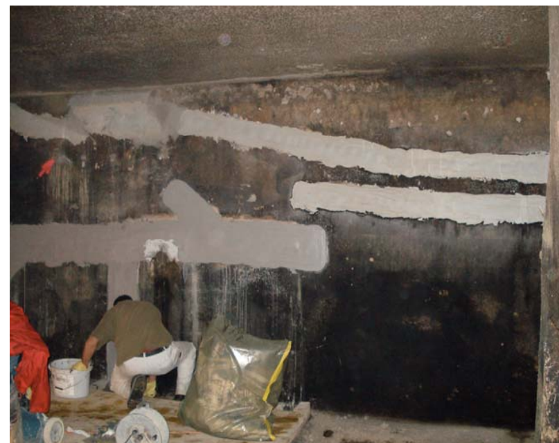
div. Risse abgedichtet mit Combiflex
