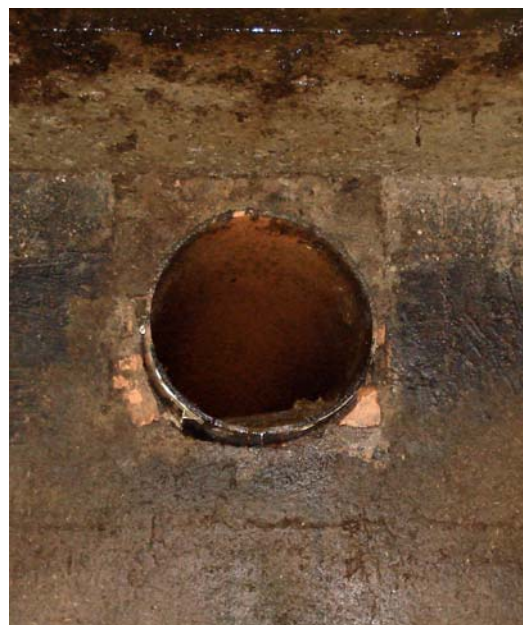
nachträglich erstellter Einlauf
