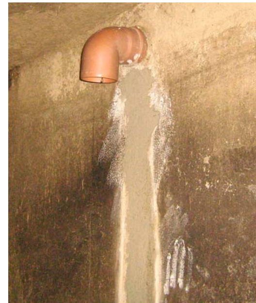
Einlauf zugemörtelt und verlängert mit Bogen
