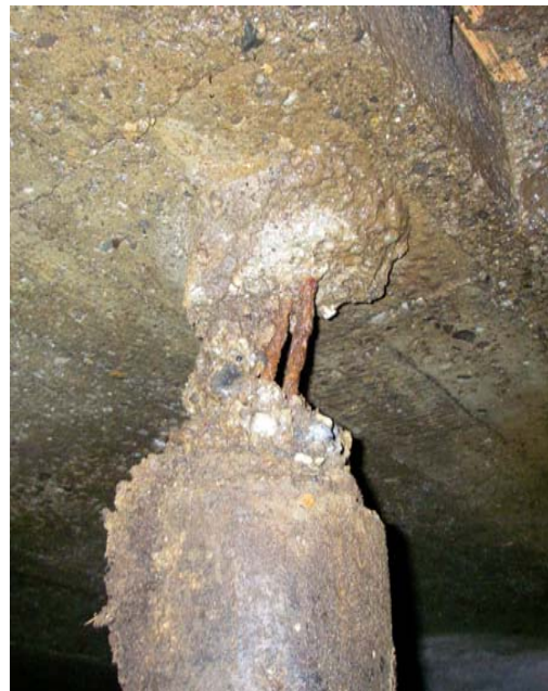
„eingeschränkte“ Tragfähigkeit einer Stütze
