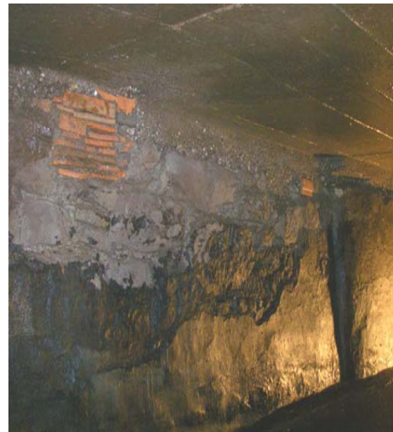
gemauerte Grubenwand
