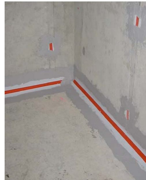
abgedichtet mit Combiflex
