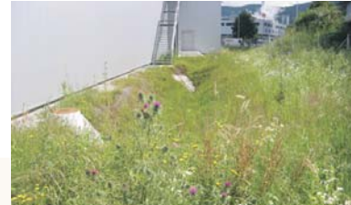
Ein gutes Beispiel für das Ausnutzen von Randzonen sind die Versickerungsmulden beim Industriebau der Prodega in Dietikon.
