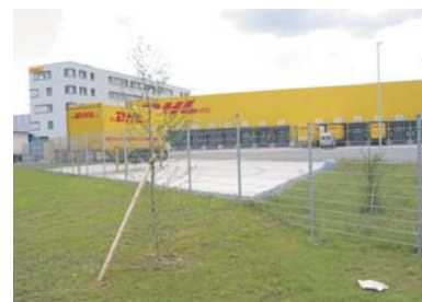
Auf der 33'500 m 2 grossen Grundstücksfläche des Gross-Verteilzentrums von DHL Express in Regensdorf werden die Grünflächen doppelt genutzt, für die Umgebungsgestaltung und für die Versickerung des Platz- und Dachwassers.
