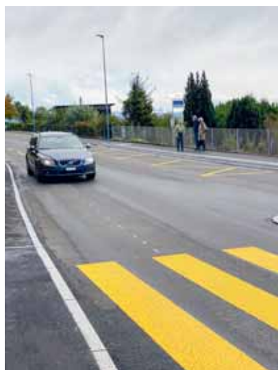
Kantonsstrasse nach Bauarbeiten mit erneuertem Belag und frischen Markierungen (Aufdorfstrasse, Männedorf). Quelle: I. Flynn
