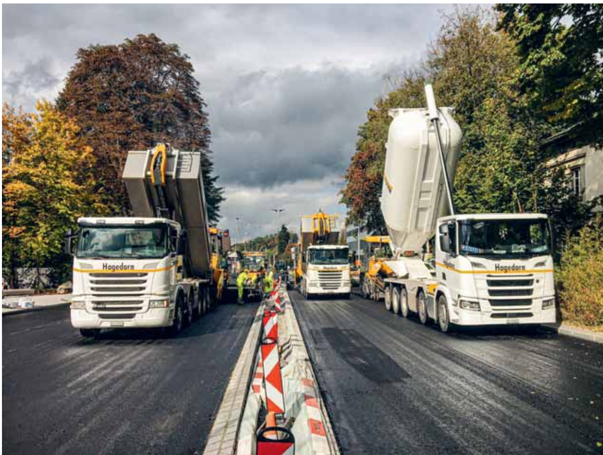
Ab 2021 liegt die strategische Planung beim neuen Amt für Mobilität, von der Vorstudie bis zum Bau wird das Tiefbauamt zuständig sein. Im Bild: Baustelle in Wetzikon. Quelle: Tiefbauamt Kanton Zürich
