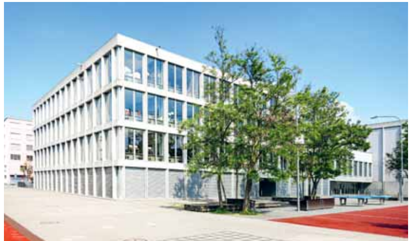
Mit dem 2004 eingeweihten Schulhaus «Im Birch» betrat die Stadt Zürich Neuland: Erstmals kam Recyclingbeton für alle vor Ort gegossenen Bauteile zum Einsatz.
