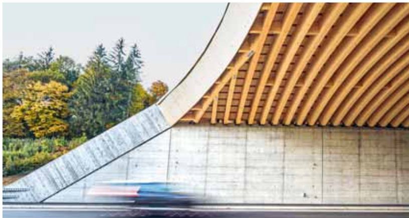
Die erste Schweizer Wildtierbrücke aus Holz führt zwischen Gränichen und Suhr über die Autobahn A1. Quelle: Timbatec, Nils Sandmeier
