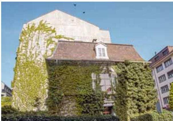
Fassadenbegrünung sowie Hecken können die aggressiv wirkenden hohen Frequenzanteile reduzieren.
