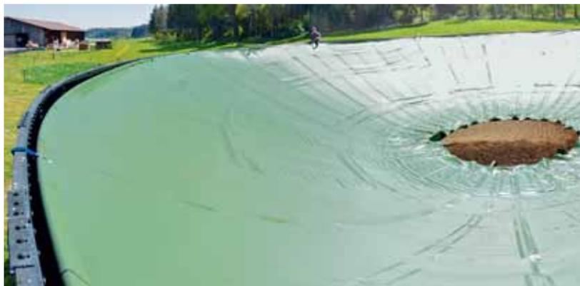
Wird ein Güllelager mit einer Teilschwimmfolie abgedeckt, reduziert dies die Ammoniakemissionen massiv.
