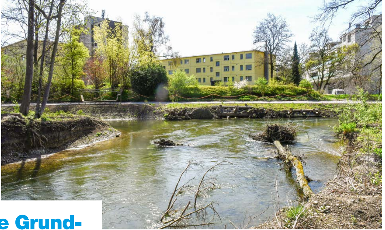
Der Auftrag zur Revitalisierung der Gewässer, hier der Glatt im Gebiet Altried bei Zürich, ist neu explizit im Wassergesetz festgehalten.
