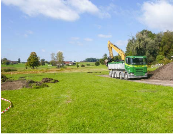
Links: Oberbodenabtrag und Abfuhr des früher aufgeschütteten Oberbodens auf der gemeindeeigenen Parzelle im Bergliriet, 2024. Nährstoffüberschuss und Schadstoffe im Boden machten die ursprüngliche Wiese wertlos für die Ökologische Infrastruktur. Rechts: Der neu geschaffene Lebensraum 2026. Er erweitert das national bedeutende Flachmoor um eine hochwertige Fläche und stärkt damit die Ökologische Infrastruktur.
