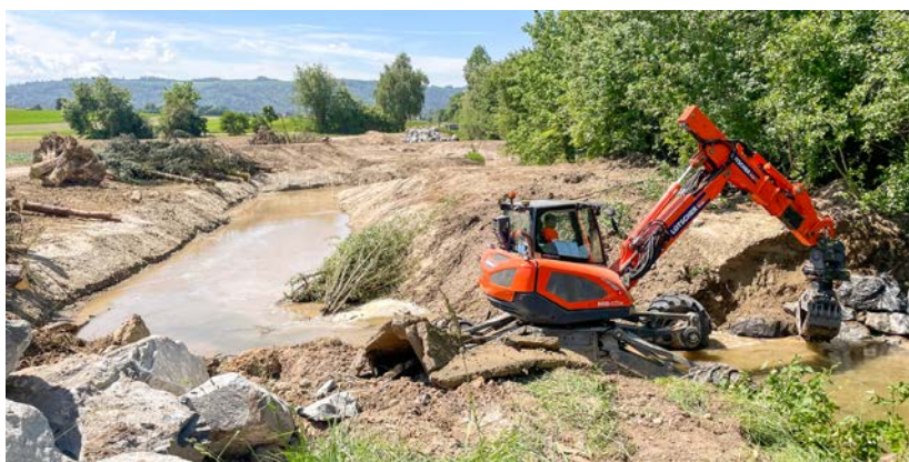
Die beiden Kantone Zürich und Aargau haben über die Kantonsgrenze hinweg bei Planung und Umsetzung gut zusammengearbeitet (das Foto zeigt die gleiche Stelle wie das Bild Seite 5, während der Bauzeit). Quelle: Marvin Koch, AWEL, Abteilung Wasserbau
