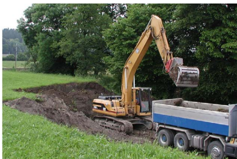
Beim Abtrag von Boden müssen die verschiedenen Horizonte sauber getrennt werden, um möglichst viel Boden sinnvoll verwerten zu können. Quelle: ALN
