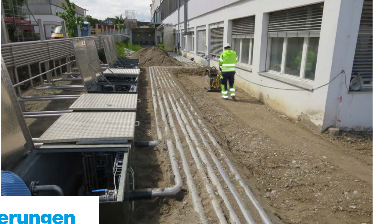
Bei einem Chemiebetrieb werden neue Tankanlagen und Rohrleitungen installiert. Das AWEL bewilligt diese Anlagen und prüft, ob die Tankvorschriften bezüglich Gewässerschutz eingehalten sind. Quelle: AWEL
