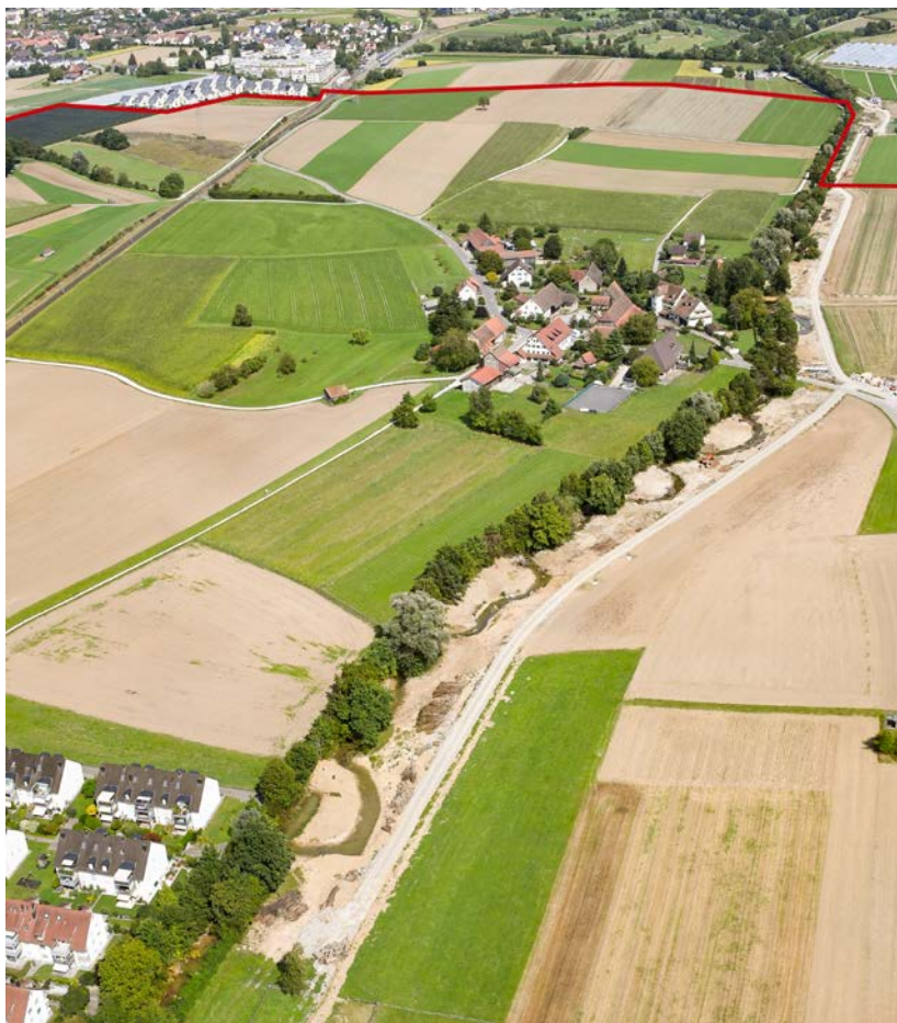
Luftbild der gesamten – 1,5 Kilometer langen – Baustelle vom Sommer 2025 (die rote Linie markiert die Kantonsgrenze). Der Bach bekommt mehr Raum und darf sich, auf den Betrachter zu, mäandrierend ausprägen. Davor folgte er in gerader Linie dem Gehölzstreifen. Unten links beginnt Würenlos.
