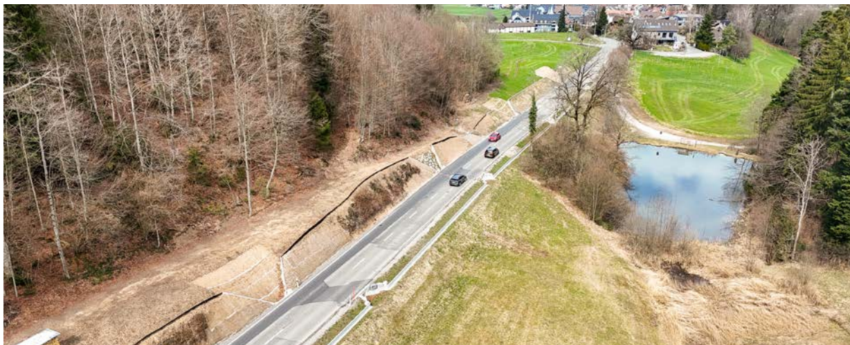
Dauerhafte Querungshilfen wie Amphibientunnel verbinden Waldlebensräume und Laichgewässer, hier beim Hummelweiher in Hittnau. Leiteinrichtungen führen die Tiere zu den Durchgängen und ermöglichen eine sichere Passage mit reduziertem Betreuungsaufwand.
