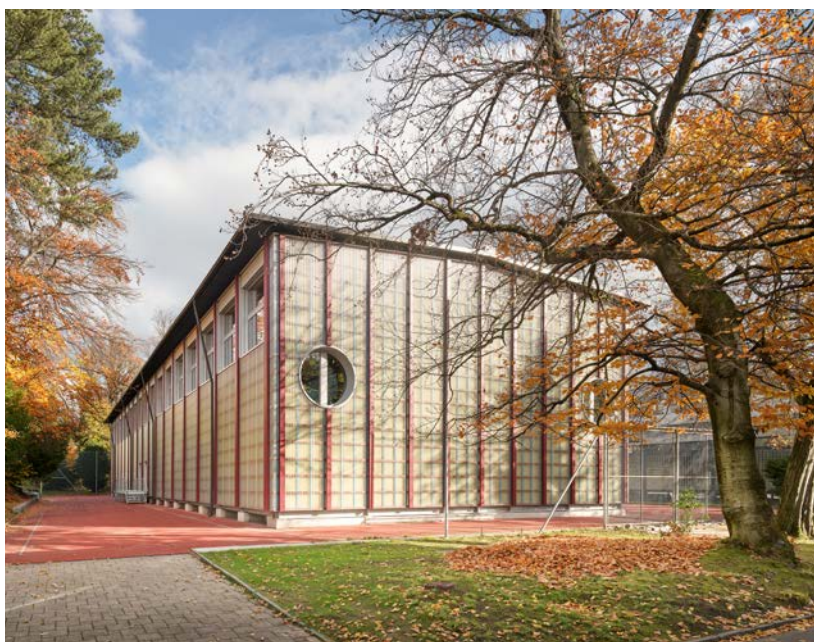
Durch die Konstruktion aus Holzmodul- und -elementbauteilen kann das Sporthallenprovisorium der Kantonsschulen Freudenberg und Enge nach der Nutzung andernorts flexibel wiederaufgebaut werden.
