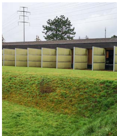
Schiessanlage mit Lägerblenden. Das sind schallabsorbierende Wände zwischen den einzelnen Schiesspositionen.
