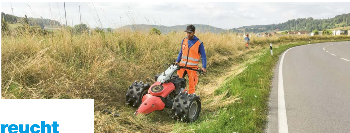
Schnitt mit einem Balkenmäher beim naturnahen Böschungsunterhalt entlang einer Kantonsstrasse. Quelle: oekoskop
