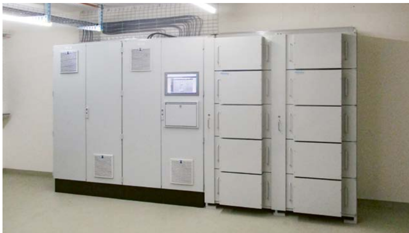
Die PV-Speicher-Kombination am Beispiel Industrie ist um viele Grössenordnungen grösser als für ein EFH, die verschiedenen Komponenten sind integriert.
