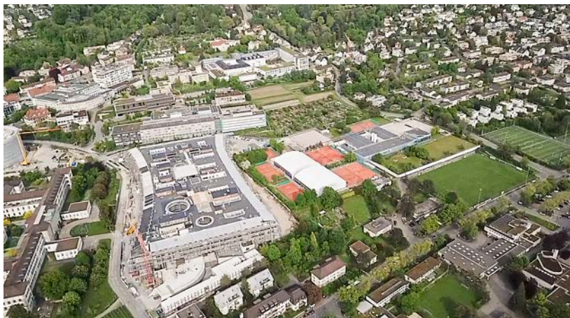
In diesem Gebiet von Zürich entsteht der Energieverbund von Energie 360° und dem Gesundheitscluster Lengg.
