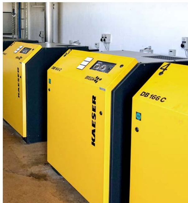
Im Belebungsbecken einer ARA (links) wird durch Gebläse (rechts) Sauerstoff eingebracht, um die Abwasserinhaltsstoffe zu oxidieren.
