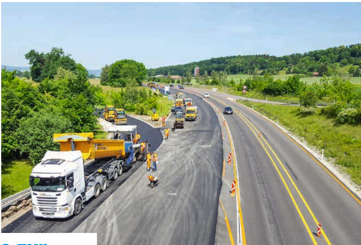
Das Tiefbauamt setzt zur Erfüllung seiner Aufgaben – beispielsweise für Strassen, Brücken und Lichtsignale – viele Ressourcen ein. Dies hat Auswirkungen auf die Umwelt. Quelle: TBA
