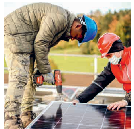
Jugendliche packen am Baustellentag an und lernen von einem Solateur. Quelle: MYBLUEPLANET
