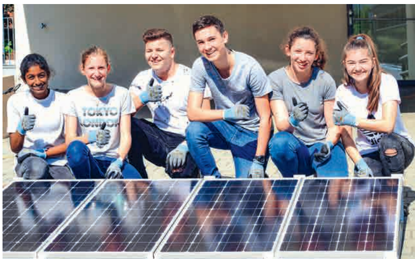
Eine stolze Schülergruppe nach dem Bau der Solaranlage auf dem eigenen Schulhausdach. Quelle: Kurier
