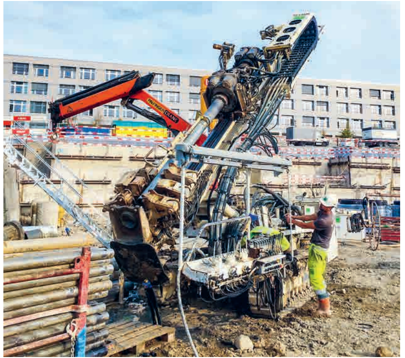
Das Bohren einer Erdwärmesonde erfordert grosses Gerät. Quelle: Helene von Vogelsang
