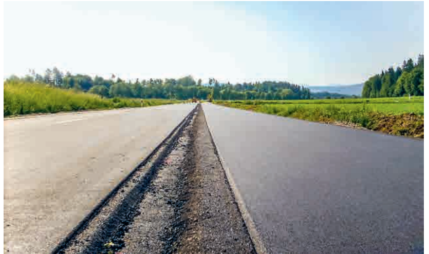
Strasse in konventioneller Bauweise mit AC T (links) und Radweg mit einer Kaltmischfundation AFK als Tragschicht (rechts) unter der jeweiligen Deckschicht. Der AFK weist eine körnigere Struktur auf und muss aufgrund der schlechteren Verdichtbarkeit breiter eingebaut werden. Quelle: TBA
