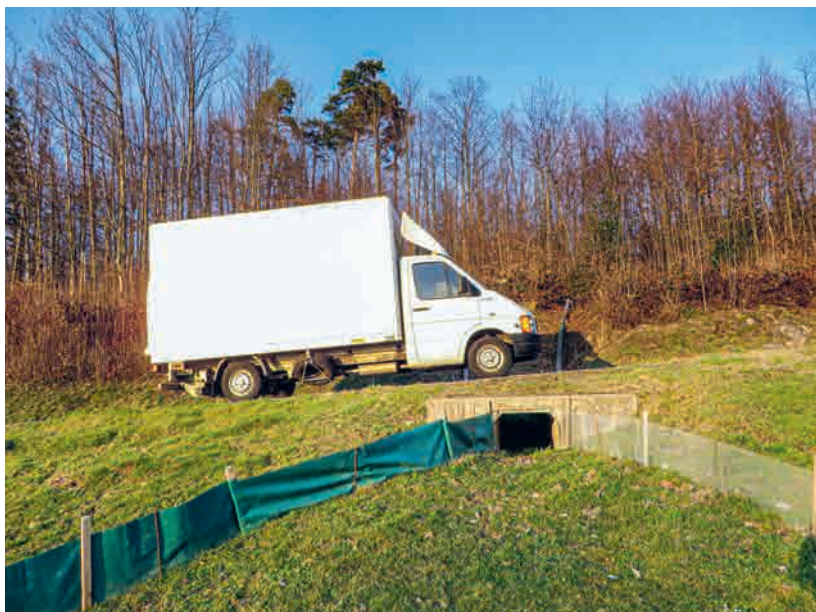
Mobile Amphibienzäune führen zu einer Kleintierunterführung, die ein gefahrloses Queren der Fahrbahn ohne helfende Hände ermöglicht. Der Geflechtzaun rechts ist für Molche überwindbar und wird nicht mehr verwendet. Quelle: Andreas Baumann
