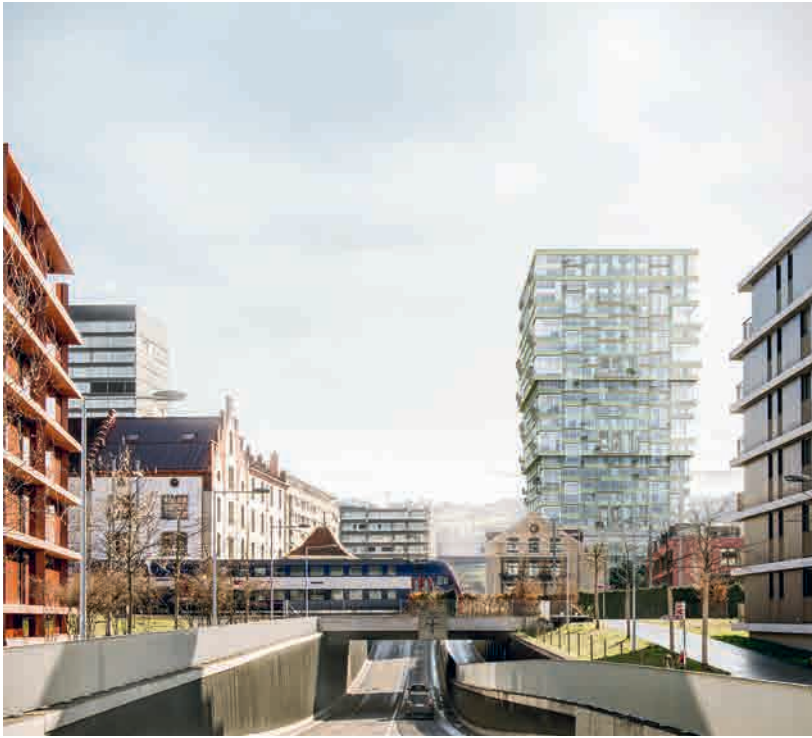
Dieser moderne 80-Meter-Turm aus Holz wird in Zug unter Beteiligung verschiedener Projektpartner gebaut. Architektur: Duplex Architekten AG, Bauherrschaft: Urban Assets Zug AG, Totalunternehmer: Implenia Schweiz AG, Holzbauingenieur: WaltGalmarini AG. Quelle: Architektur: Duplex Architekten, Visualisierung: Filippo Bolognese
