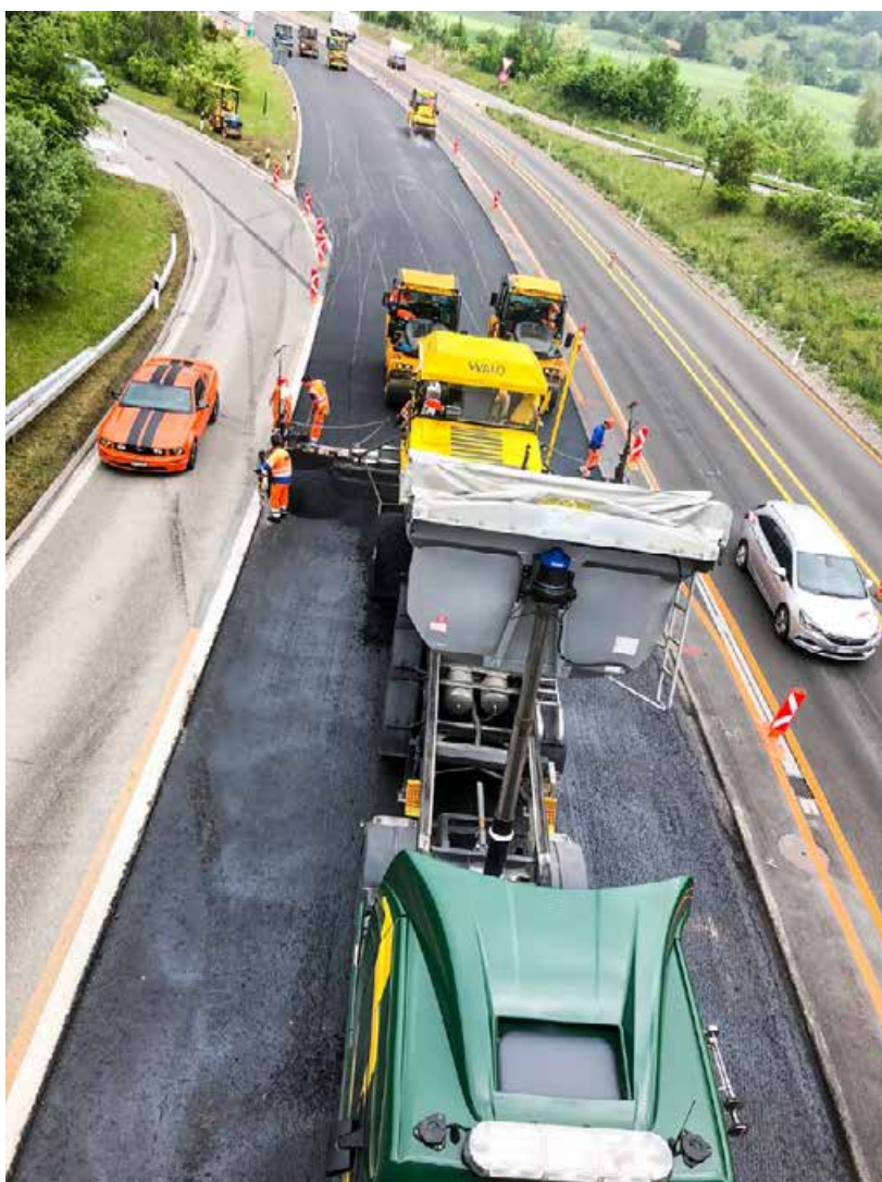
Arbeiten bei fliessendem Verkehr erfordern gute Planung und Begleitmassnahmen, wie hier beim Einbau von Ausbauasphalt 2018 an der A51. Quelle: Urs Schellenberg, TBA/O+G
