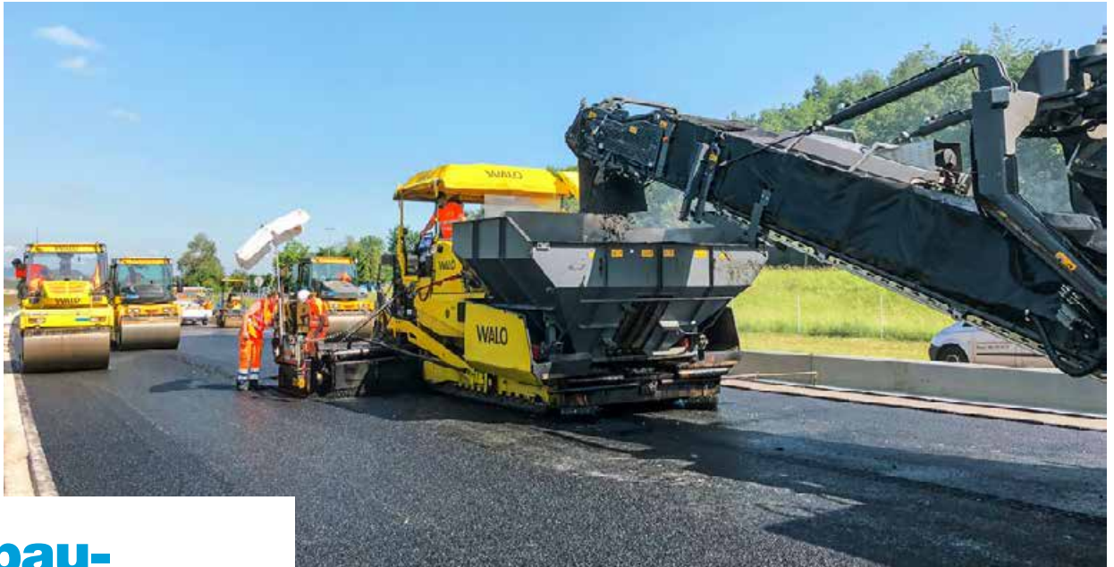
Einbauphase des Ausbausasphalts in die Kantonsstrasse A51 bei Bülach-Kloten, 2018. Quelle: Urs Schellenberg, TBA/O+G
