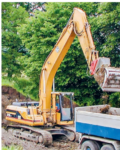
Boden wird abgetragen und einer externen Verwertung zugeführt. Quelle: FaBo
