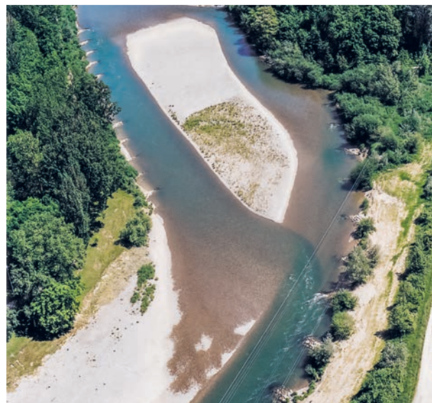
Thur-Ausweitung bei Gütighausen links vor, rechts nach der Revitalisierung. Quelle: Vorher Foto links: AGW, ca. 1975; Nachher Foto rechts, ca. 2000: SAF
