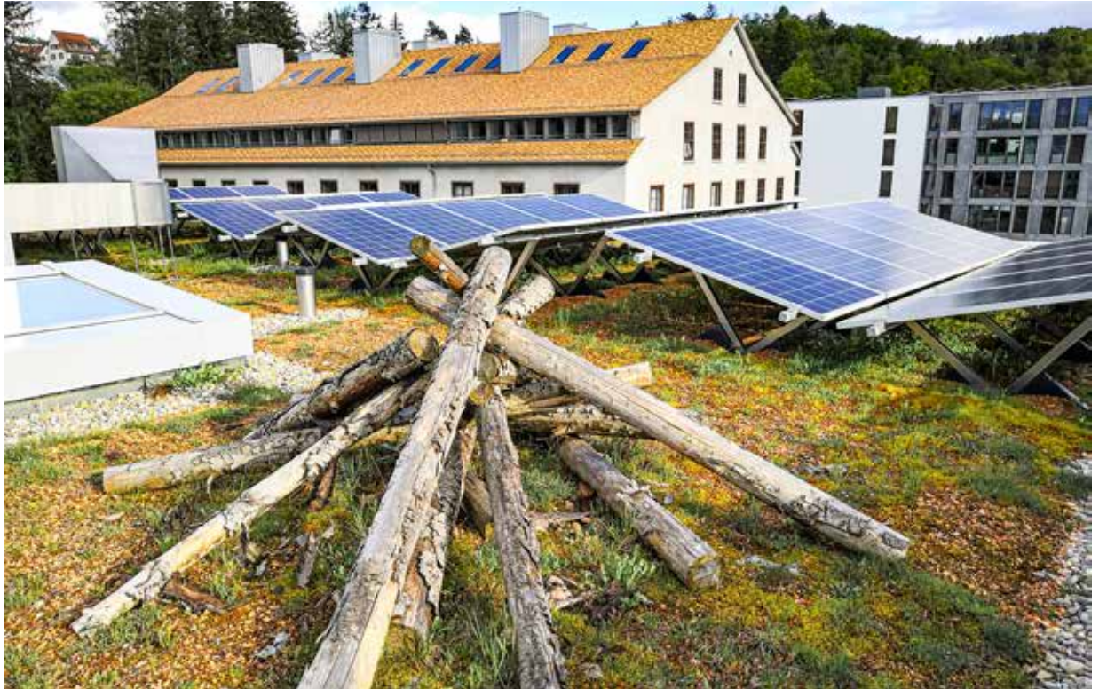
Das ideale Gründach: Solaranlage, Kleinstrukturen und ökologische Begrünung werden kombiniert (Greencity). Quelle: GSZ
