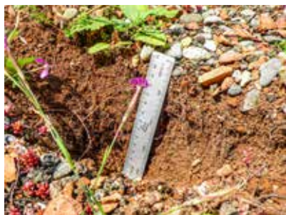
Mindestens zehn Zentimeter (verdichtetes) Qualitätssubstrat. Quelle: GSZ
