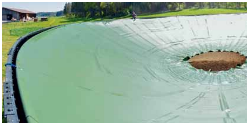
Wird ein Güllelager mit einer Teilschwimmfolie abgedeckt, reduziert dies die Ammoniakemissionen massiv. Quelle: AWEL
