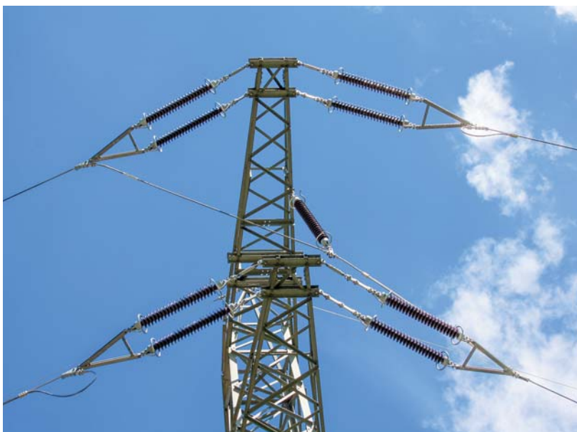
Bewilligungsverfahren für Hochspannungsleitungen erstrecken sich oft über mehr als fünfzehn Jahre.
