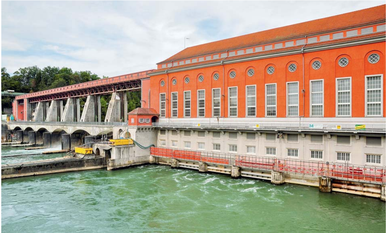
Dank Wasserkraftwerken, wie hier bei Eglisau, enthält der Schweizer Strommix 60 Prozent erneuerbare Energie. Quelle: Roland ZH, Wikimedia Commons (CC BY-SA 3.0)
