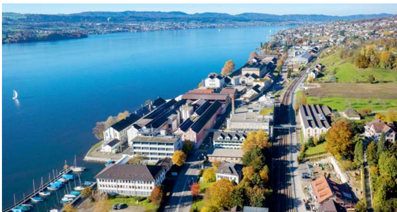
Gebietsplanung Chance Uetikon: Am Ort der ehemaligen Chemiefabrik könnte ganz Verschiedenes entwickelt werden: Park, Kantonsschule, Wohnungen ... Der Einbezug der Bevölkerung an der künftigen Entwicklung wird durch Beteiligungsveranstaltungen gesichert.
