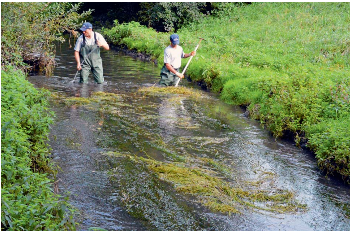
Der Gewässerunterhalt gewährleistet das Abflussprofil der Gewässer und befestigt die Dämme und Uferbereiche. Dazu braucht es viel Mechanisierung mit hohem Wirkungsgrad und noch immer auch viel Handarbeit.
