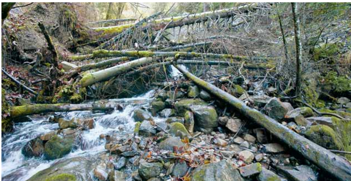
Umgestürzte Bäume sowie Schwemmholz können zu Verklaunung und in der Folge zu Hochwasserschäden führen.
