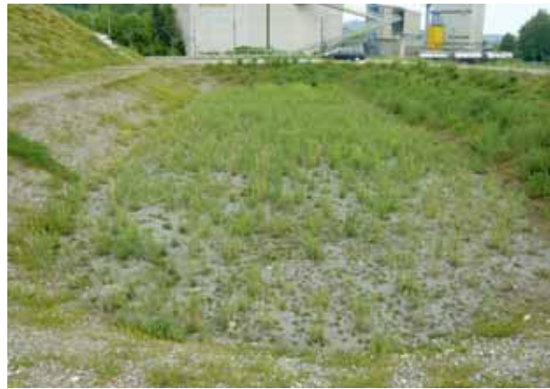
Becken Ost der SABA Ristet Mai 2007.
