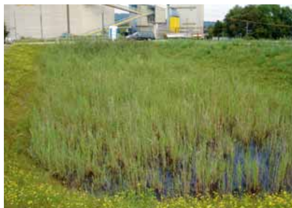
Becken Ost der SABA Ristet August 2009.
