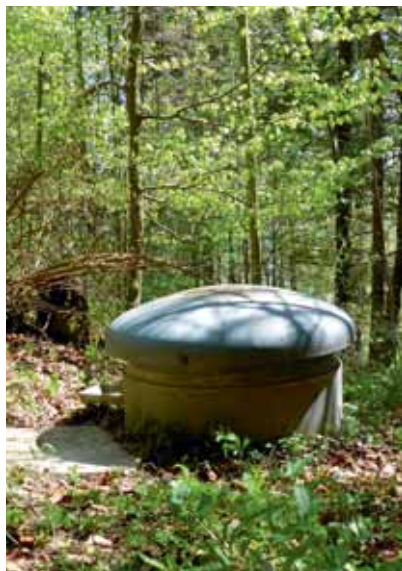
Brunnenstuben werden dort gebaut, wo das Grundwasser zu Tage tritt. Quelle: Beat Koller, AWEL, Abt. Gewässerschutz
