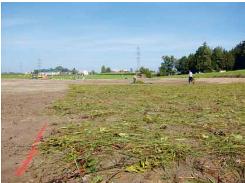
Direktbegrünung in Ausführung: Das frische Schnittgut wird locker auf den vegetationsfreien Boden der «künftigen Wiese» verteilt. Quelle: Dany Kreiner
