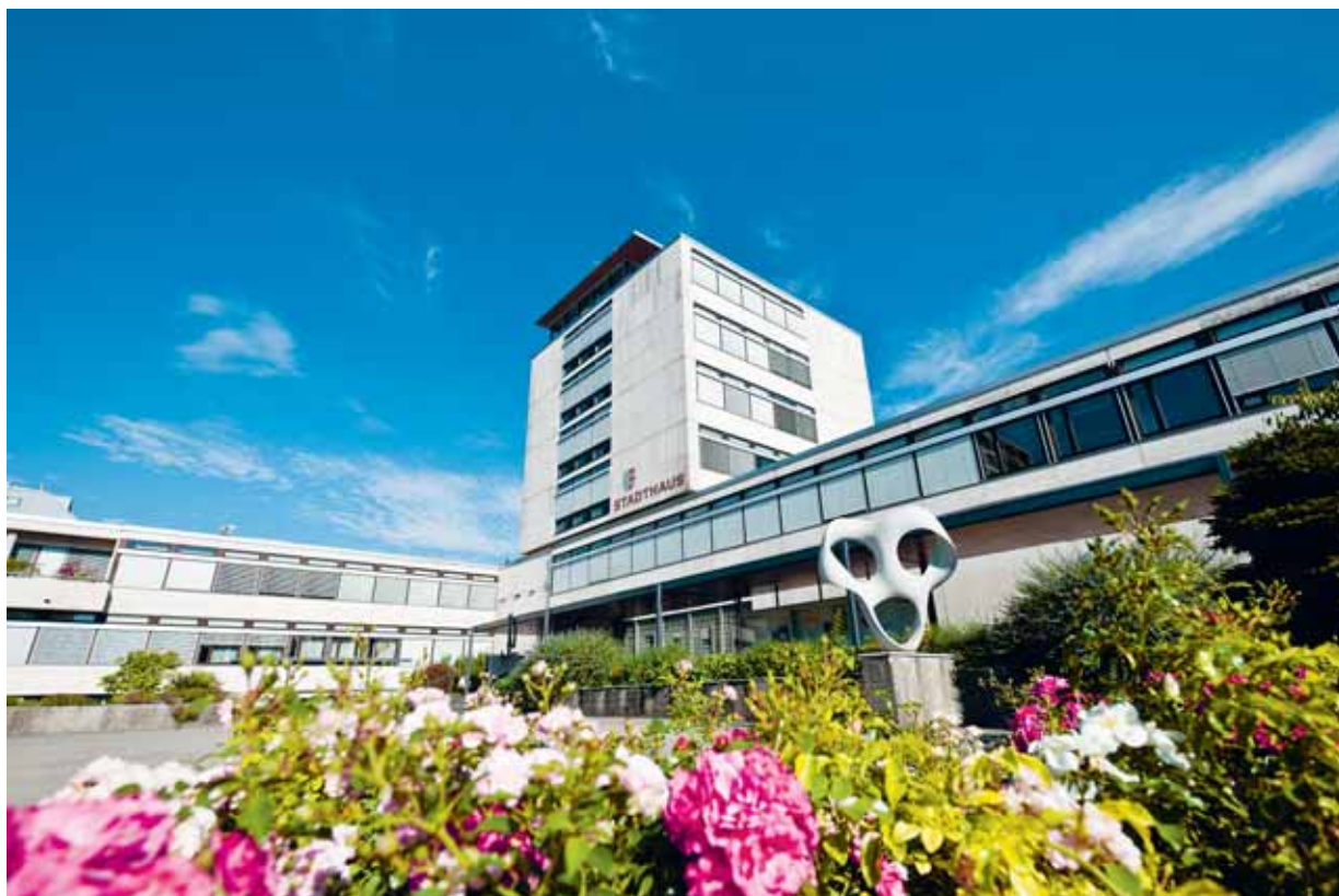
Die Gebäudeautomation hat massgeblichen Einfluss auf die Energieeffizienz eines Gebäudes. Durch die Installation eines modernen Gebäudemanagement-Systems hat das Stadthaus in Uster die Effizienzklasse A gemäss SIA Norm 386.110 erreicht. Quelle: Stadt Uster
