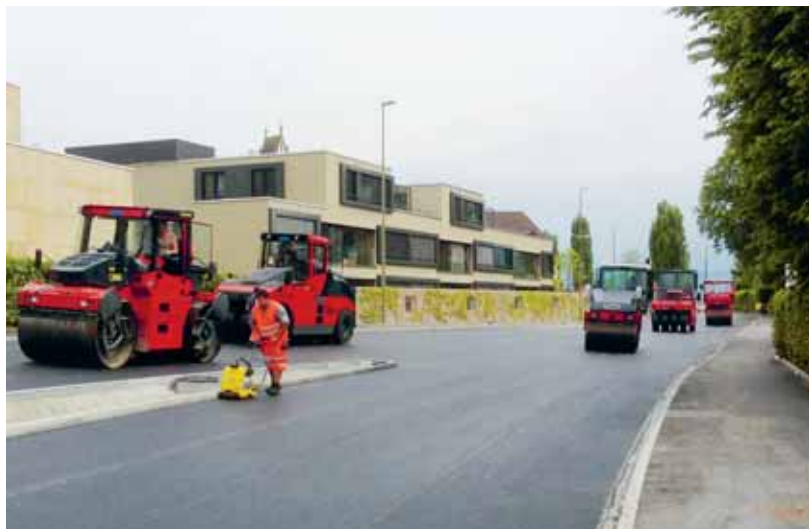
Lärmarme Beläge als Massnahme an der Quelle sind effizient, da sie den Lärm am Ort der Entstehung reduzieren. Quelle: TBA
