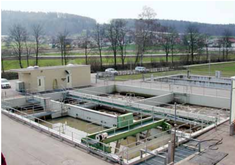
Die Firma eisberg AG arbeitet eng mit der lokalen Kläranlage sowie der Gemeinde Dänikon zusammen, um gemeinsam gute Lösungen zu finden. Quelle: AWEL
