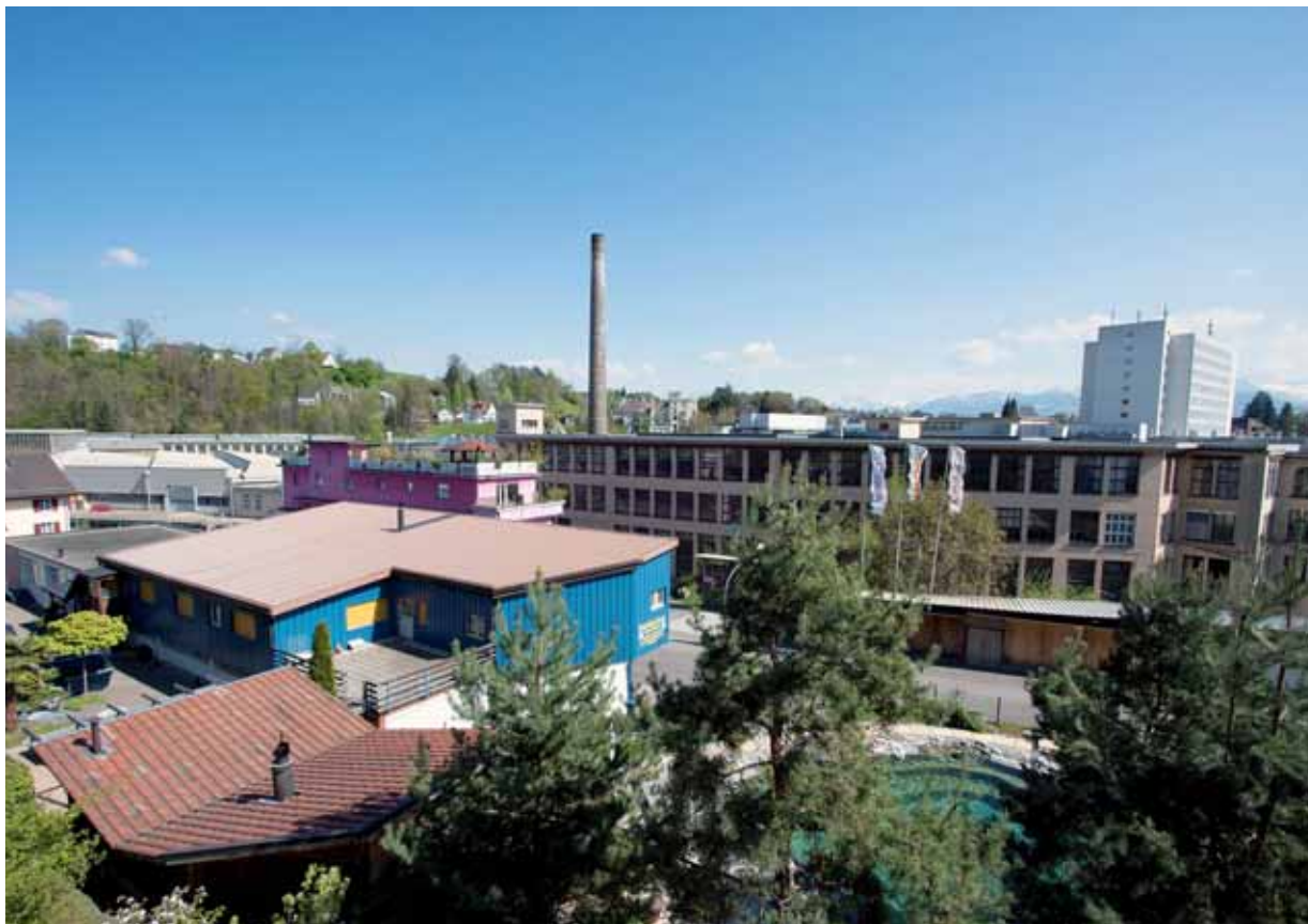
Eine wirtschaftlich tragfähige räumliche Entwicklung wird möglich, indem insbesondere auch Standorte für Industrie, Gewerbe und Logistik gesichert werden. Quelle: ARE
