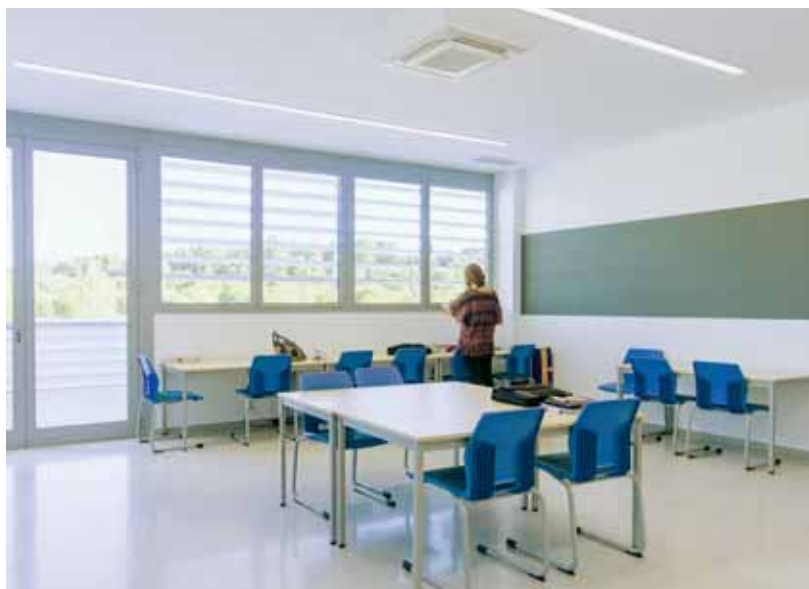
In vielen Fällen können LED herkömmliche Leuchtmittel 1:1 ersetzen – nur energieeffizienter. Im Bild: Klassenzimmer mit LED-Leuchtkörpern. Quelle: Philips Communications
