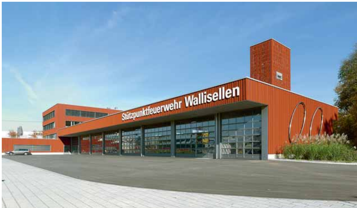
Beim Feuerwehrneubau in Wallisellen kam Schweizer FSC-Holz zur Anwendung. Quelle: Gemeinde Wallisellen
