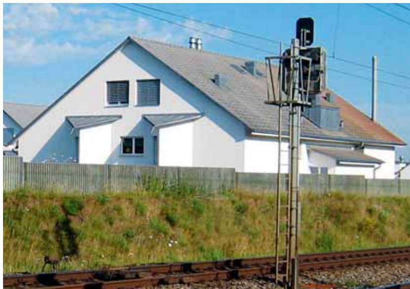
Lüftung mit offenem, lärmabgewandtem Erker-Fenster, Lösung der LSV seit 1987. Der Lärmschutz bei Bahnlärm beträgt gegenüber der lärmexponierten Fassade -7 bis -10 dB. Quelle: FALS
