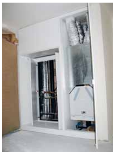
Das Lüftungsgerät im Schrank beim Eingang erleichtert den Zugang zur Wartung. Quelle: Zehnder Schweiz AG
