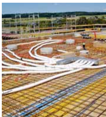
Eingelegte Lüftungsrohre in der Geschosdecke. Quelle: Zehnder Schweiz AG
