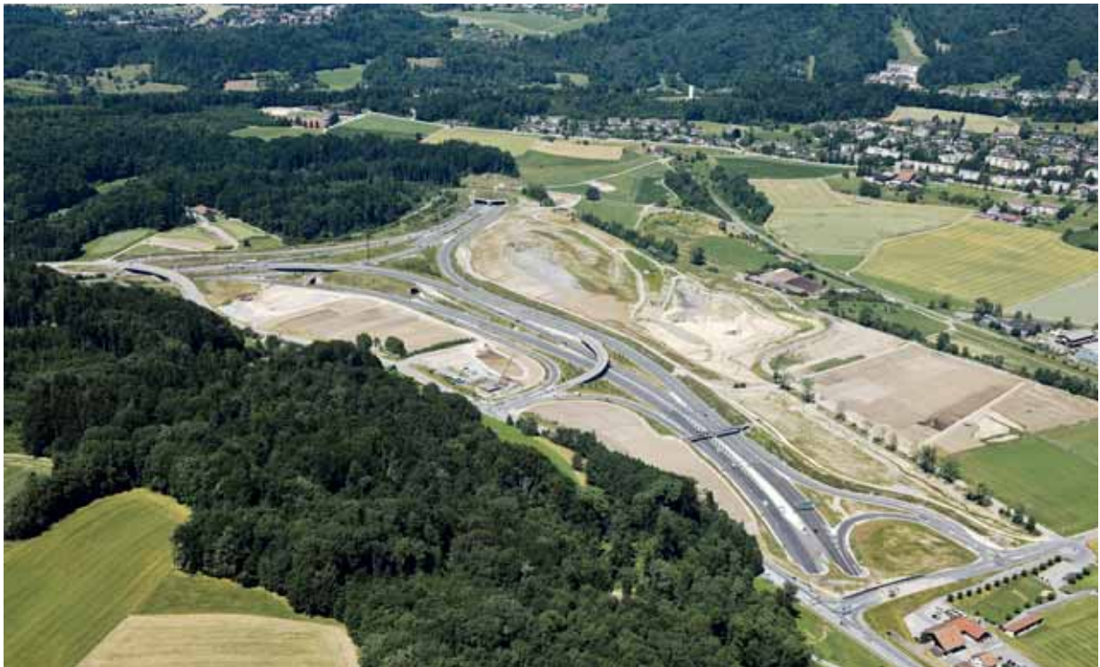
Aus der Luft gut zu erkennen ist das neu gebaute Autobahndreieck. Im Hintergrund ist die Ortschaft Wettswil zu sehen. Quelle: Schweizer Luftwaffe, 2010
