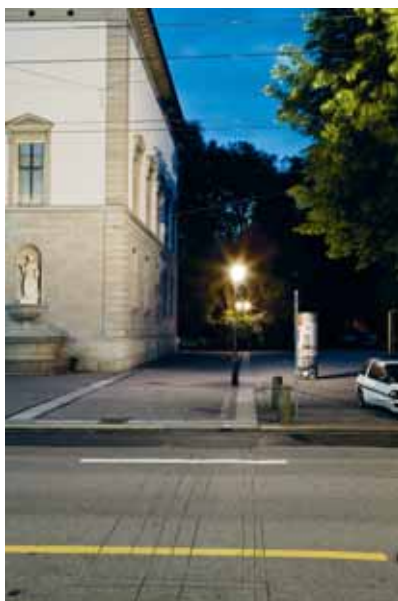
LED-Leuchten erlauben eine energieeffiziente und zielgerichtete Beleuchtung.
