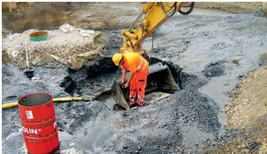
Sanierung eines Ölschadens im Zusammenhang mit einem Neubau.
