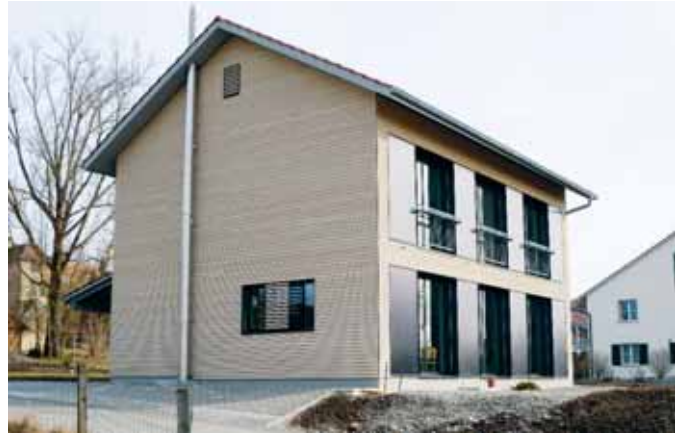
In die Fassade integrierte Solaranlagen können wie hier in Benken bei guter Einordnung zum positiv prägenden Gestaltungselement werden.
