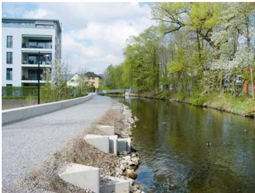
Genügend Gewässerraum, wie hier am Aabach beim Stadtpark in Uster, ermöglicht neben dem Hochwasserschutz auch den Zugang zum Gewässer.
